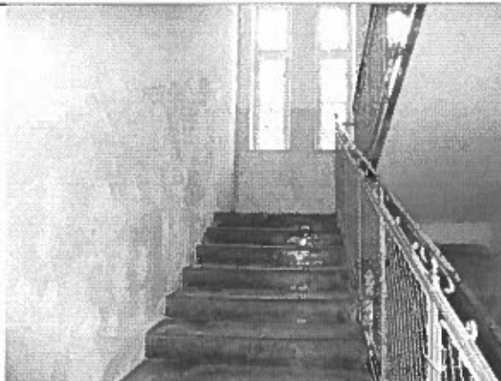
lépcsőház felújítás alatt
